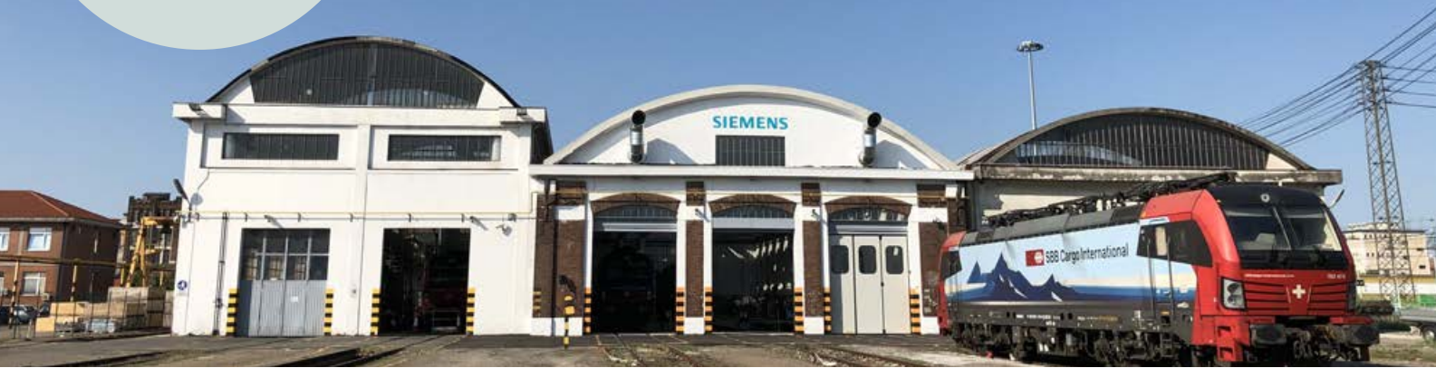
Das Rail Service Center in Novara (Italien) ist spezialisiert auf die präventive und korrektive Instandhaltung aller Lokomotiven-Komponenten, einschließlich der Signalsysteme.
