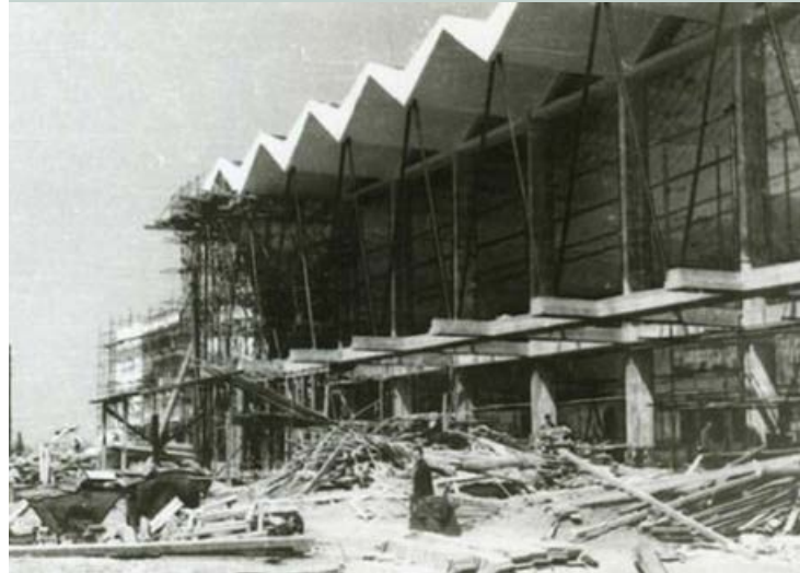
Ein historisches Foto von den Bauarbeiten 1963 zeigt die Betontträger und die Metallstreben, die das Vordach über dem Eingang zum Bahnhofsgelände in Novi Sad hielten.
