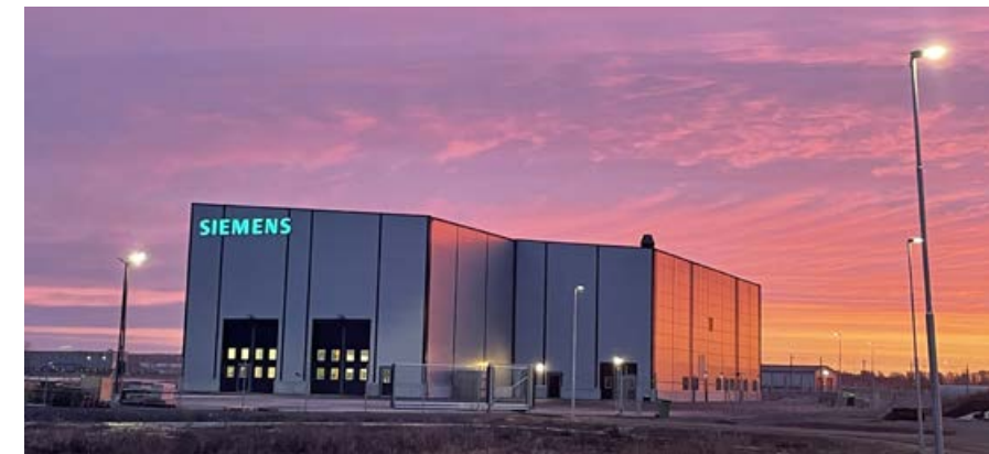
Das Rail Service Center in Hallsberg (Schweden) wurde im Oktober 2022 in Betrieb genommen und ist damit eine der jüngsten Erweiterungen des Depot- und Servicenetzwerks von Siemens Mobility. Die dortigen Experten kümmern sich um die Instandhaltung von Lokomotiven, wobei der Schwerpunkt auf Überholungen und Unfallreparaturen liegt.
