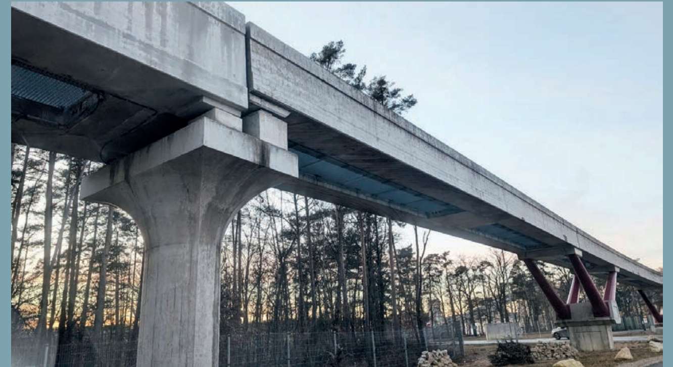
Aufgeständerter Fahrweg mit Brückensektion.
