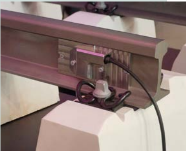
Sensoren helfen, Bahnstrecken zu überwachen.
