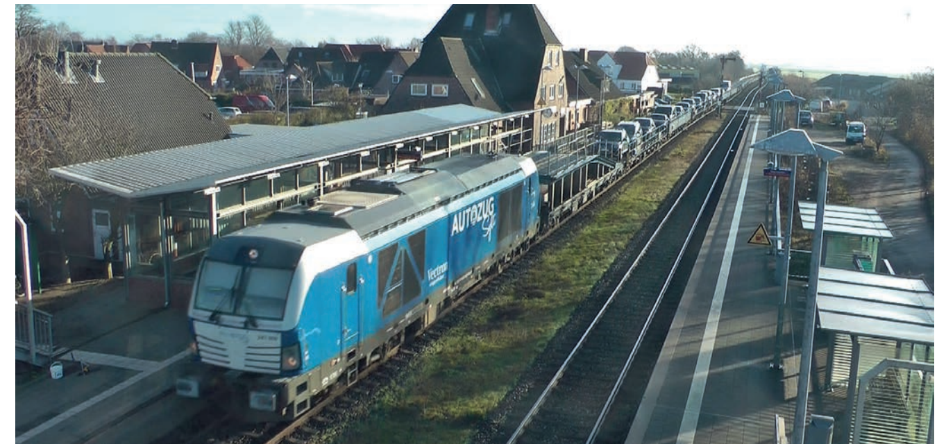
Die Marschbahn von Elmshorn bis Westerland auf Sylt soll bis auf den auf die Insel Sylt führenden Hindenburgdamm zweigleisig werden. Hier eine bereits bestehende zweigleisige Ausweichstelle in Klanxbüll.
