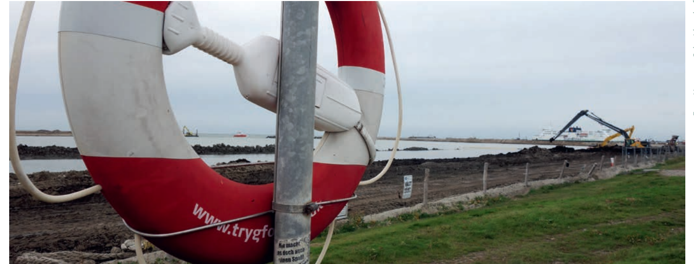
In Rødby laufen die Arbeiten auf Hochtouren.
