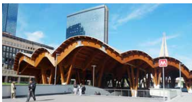
Spektakulär ist die Metro von Neapel schon durch die Gestaltung des Eingangsportals. The Naples Metro is spectacular, and not just because of the design of its entrance portal.
