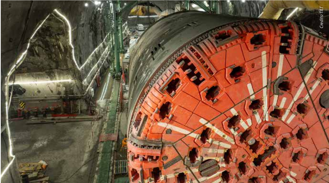
Tunnelbau 2025 im Abschnitt Saint Martin la Porte. Tunnelling in 2025 in the Saint Martin la Porte section.
