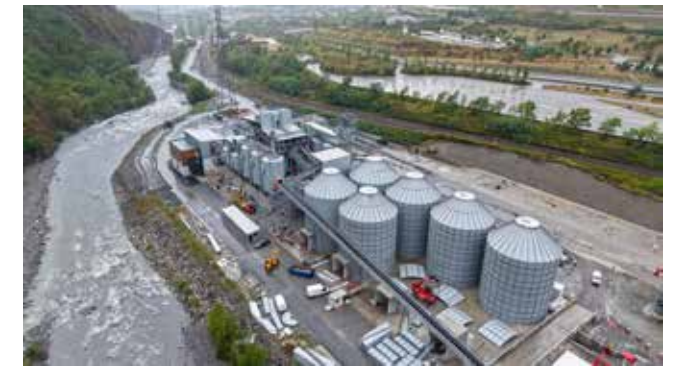
... und 2025 als fertiger Bauplatz einer VINCI-Tochtergesellschaft am Abschnitt CO11 in ILLAZ (Gemeinde Saint-Julien-Montdenis). ... and 2025 a VINCI Construction subsidiary CO11 at Illaz (Saint-Julien-Montdenis municipality) 2025 Excavated Material Treatment Plant. Credits: TELT
