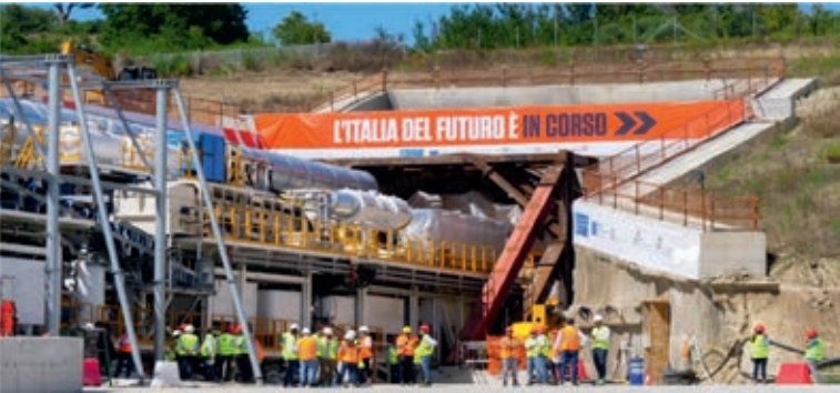
„The Italy of the future is underway”: a tunnel construction site of the RFI. Numeri impressionanti: nel 2024, RFI ha investito 9,63 miliardi di euro nella rete. Con 814,4 milioni di passeggeri ferroviari nel 2023, l'Italia si colloca al terzo posto nelle statistiche UE dopo Germania e Francia.
