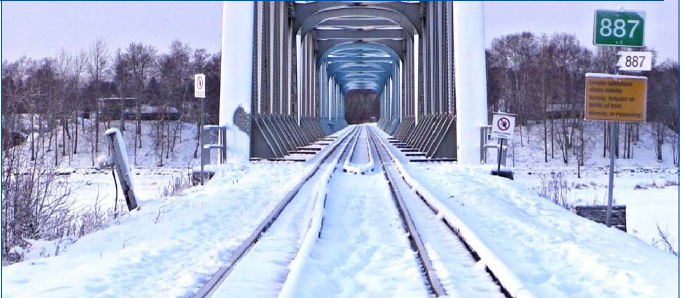
Mit vier Gleisen: die Grenzbrücke nach Haparanda von Tornio gesehen. With four tracks: the border bridge to Haparanda seen from Tornio.
