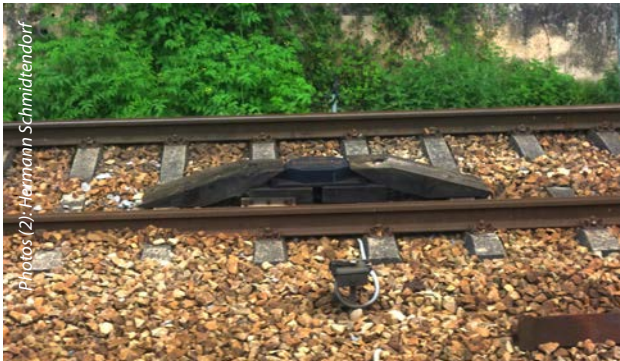
Populär in Spanien: Eine ASFA-Balise Auf der Bahnstrecke bei Campomanes.
