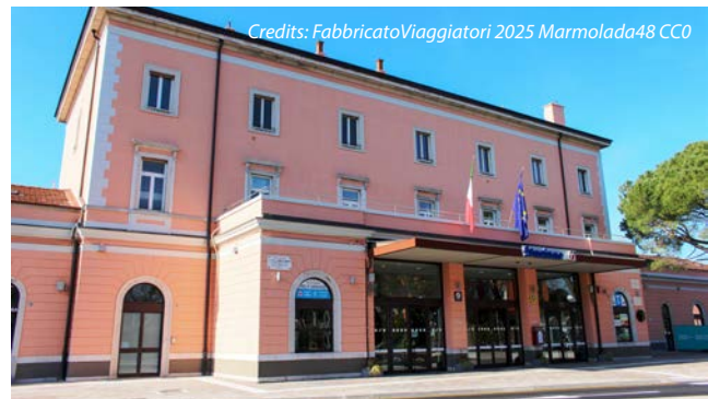
Bahnhof/Train Station Stazione FS Gorizia Centrale.
